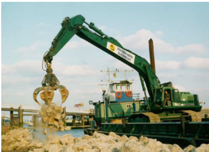
Foto 2 oeverwerk, ook met milieu-eisen
