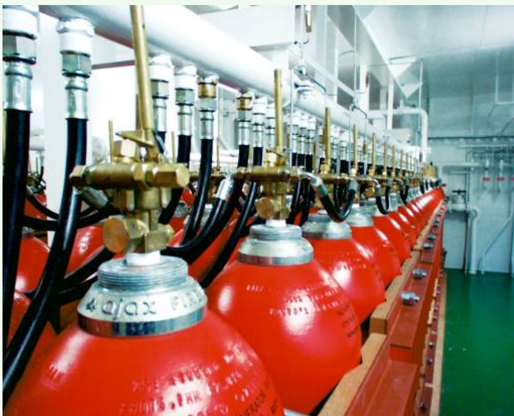
voorbeeld van vaste brandblusinstallatie
