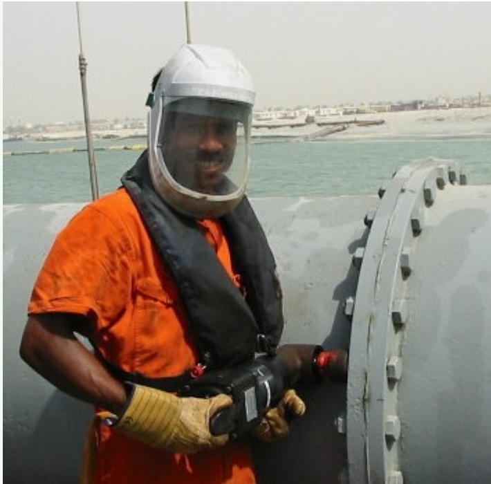
aanslaan van moeren met een luchttol
