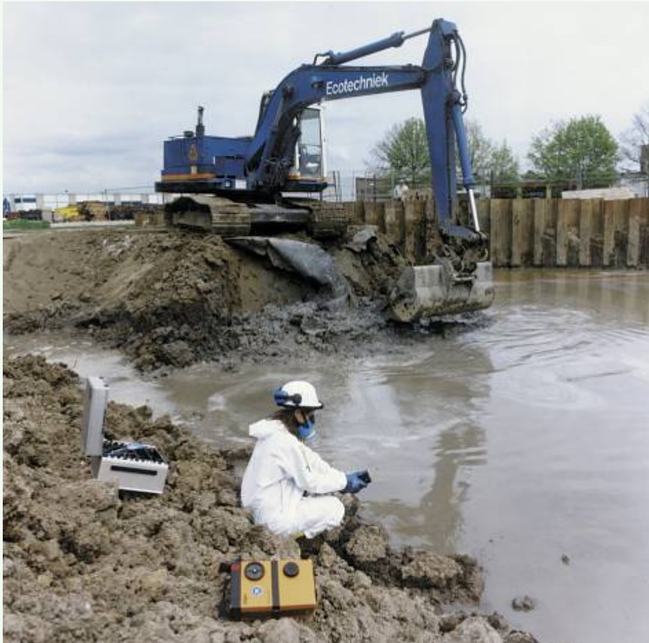
voorbeeld van werken in speciale kleding en met adembescherming
