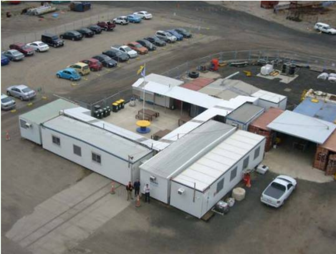
Projectkantoor met werkplaats
