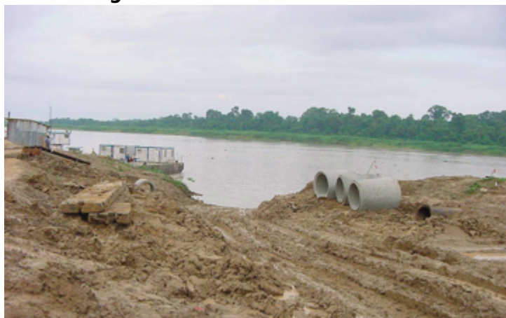
Foto 11 aanvoer weg voor materieel vanaf waterzijde
