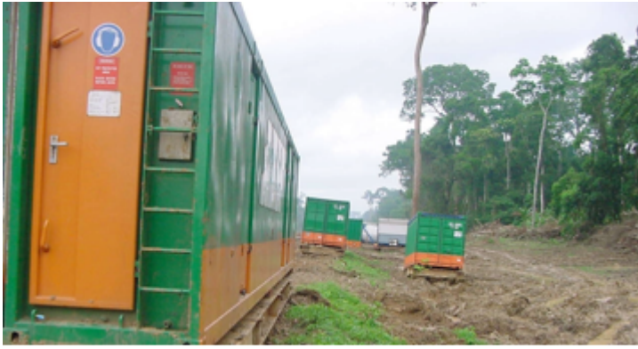
Foto 10 aanvoer van een tussenstation op locatie.
