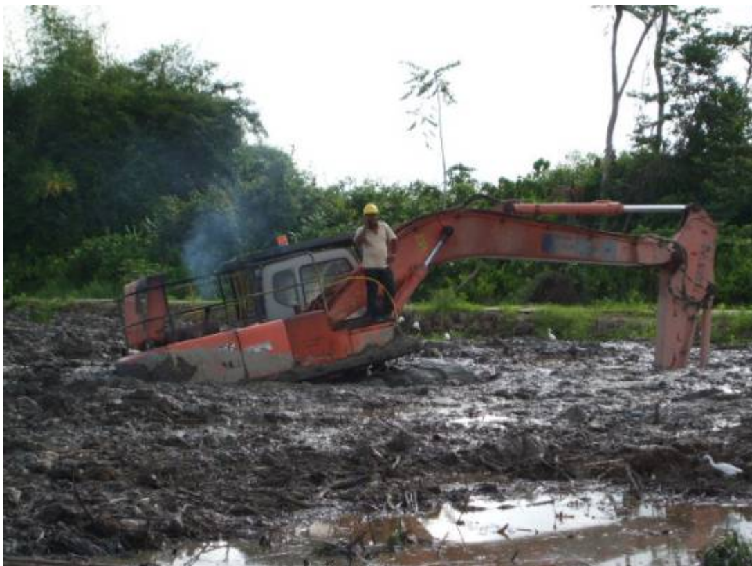
hydraulische graafmachine weggezakt
