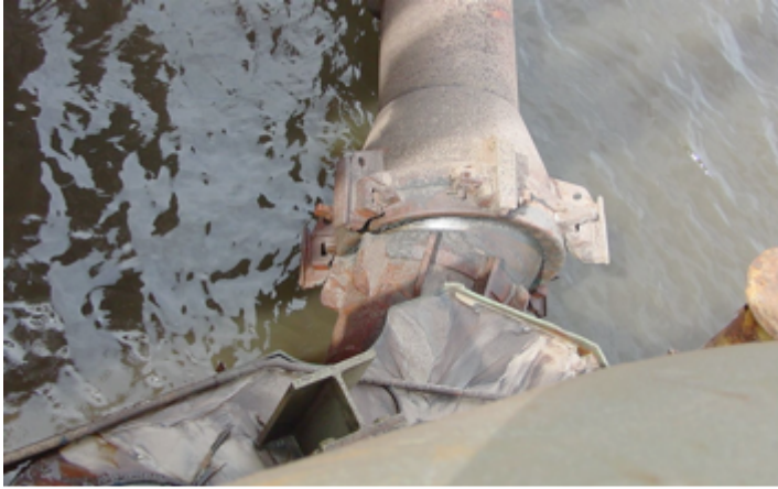
Foto 22 Koppeling van een werktuig met drijvende leiding
