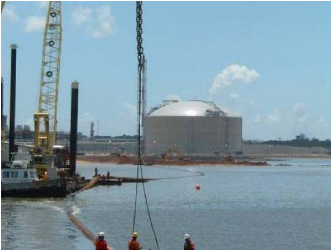
leggen van een zinkerleiding
