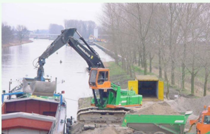
Foto 16 tijdelijke losplaats met mobiele kraan en dumper
