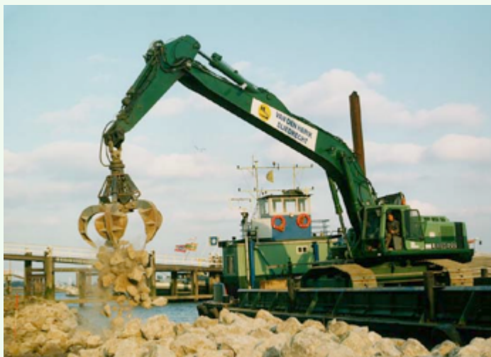
Foto van een baggerkraan uitgerust met grijper
