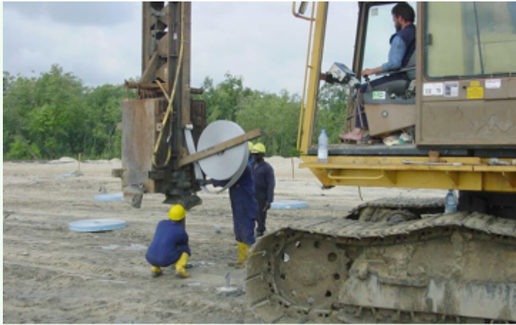
Foto 38 verticale drainagemachine
