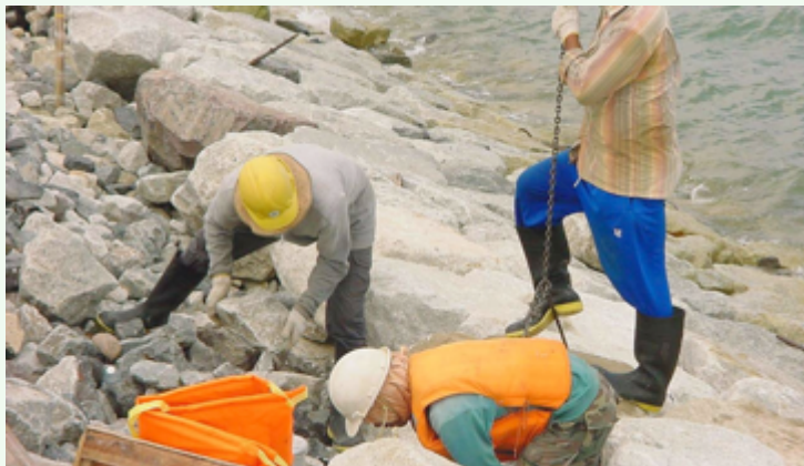
Zetwerk talud, golfslag
