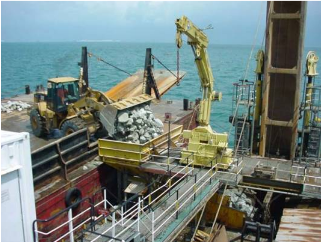
wheelloader stort stenen vanaf het dek van de stenenbak in een stortkoker
