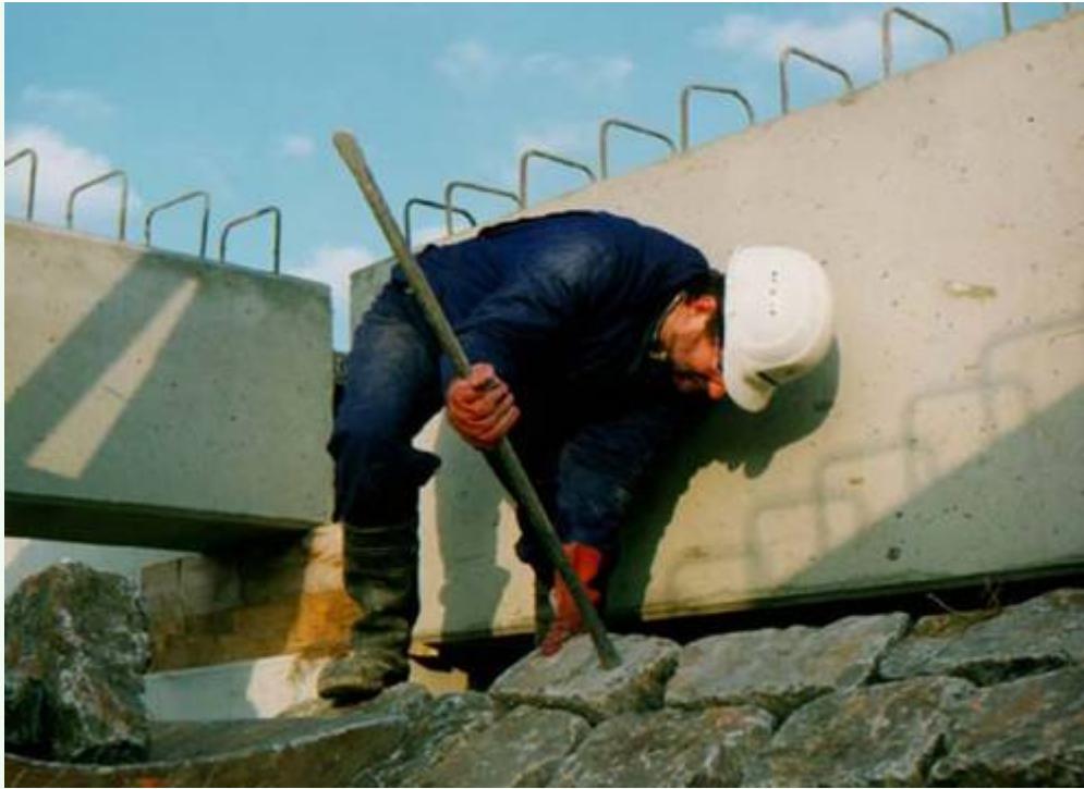
gebruik van stootijzer
