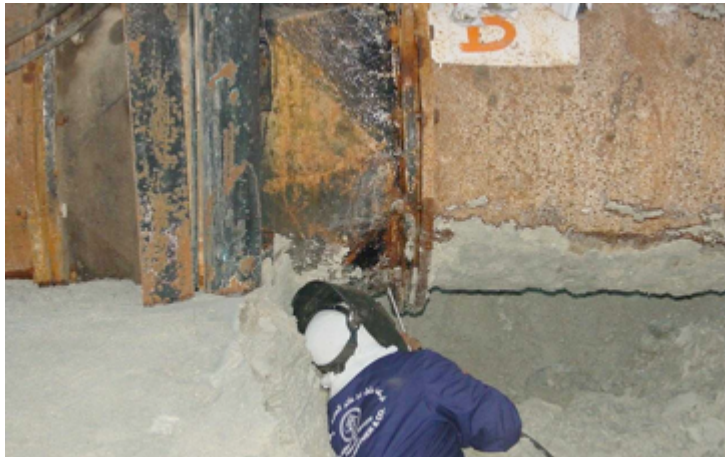
lassen in put onder leiding op stort
