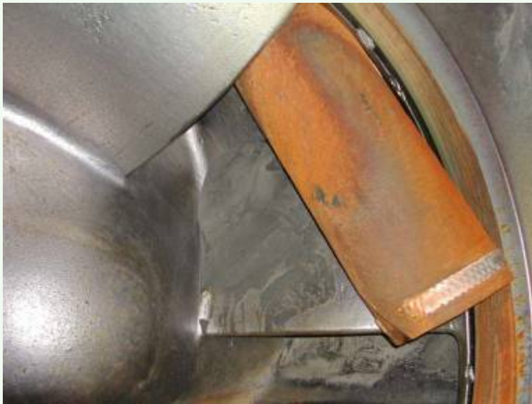
explosief (28cm) aangetroffen in waaier van zandpomp
