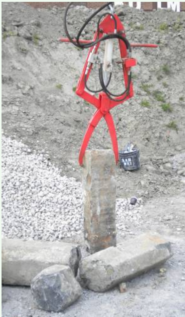
mechanisch zetten met hydraulische steenzettang
