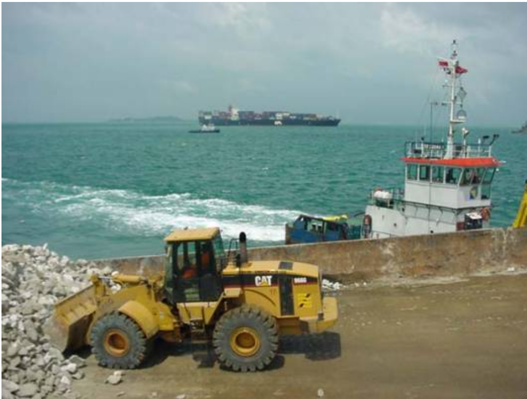
wheelloader schept stenen vanaf het dek van een stenenbak
