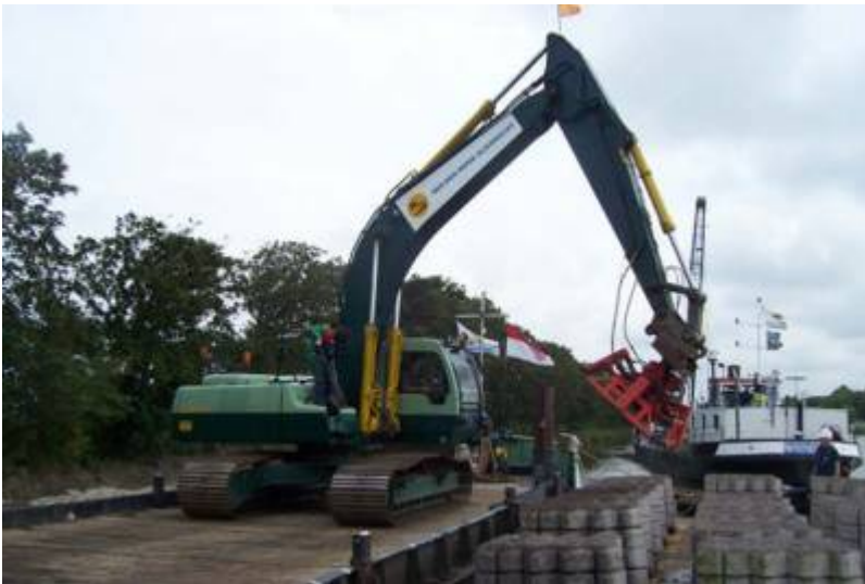
Betonklem aan kraan
